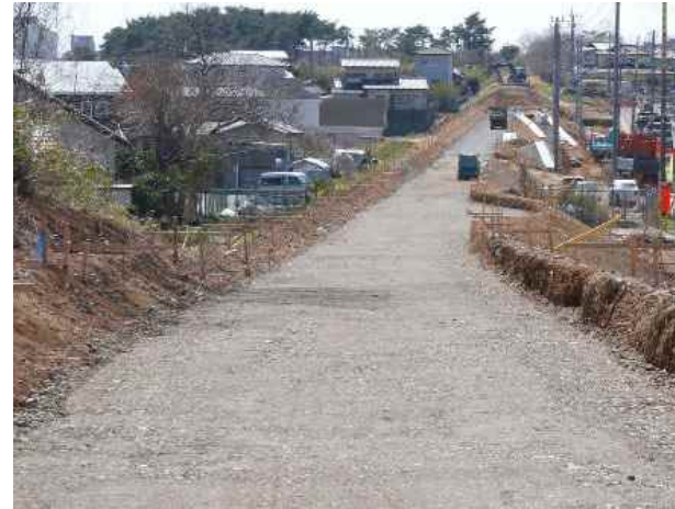
鉄道の廃線跡地に専用道路を敷設*1
