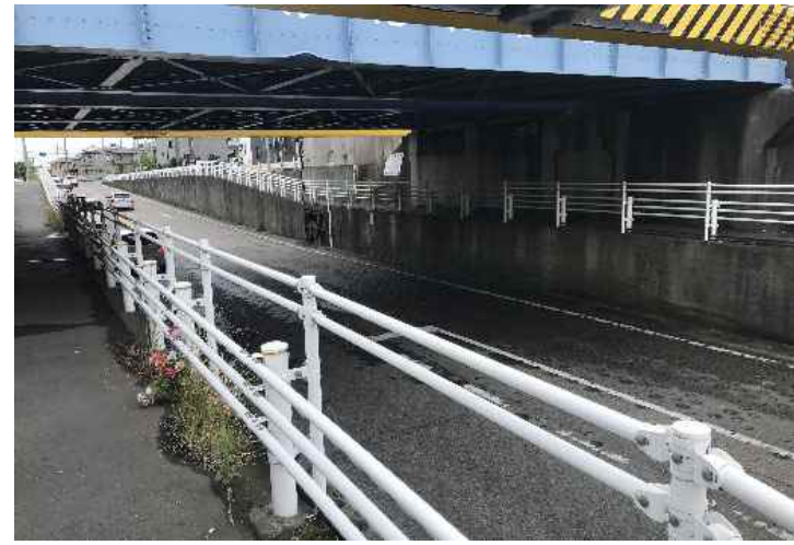
高架橋の下をくぐるアンダーパス
