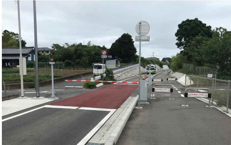
一般車両の進入を防ぐバースゲート
