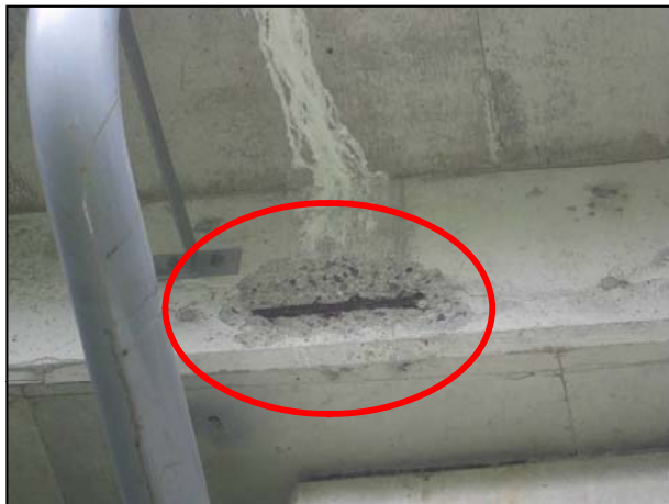
主桁の損傷
