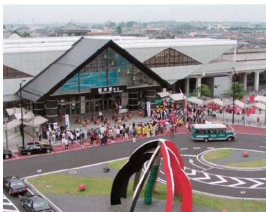
鉄道駅アクセス道路整備〔栃木市〕
