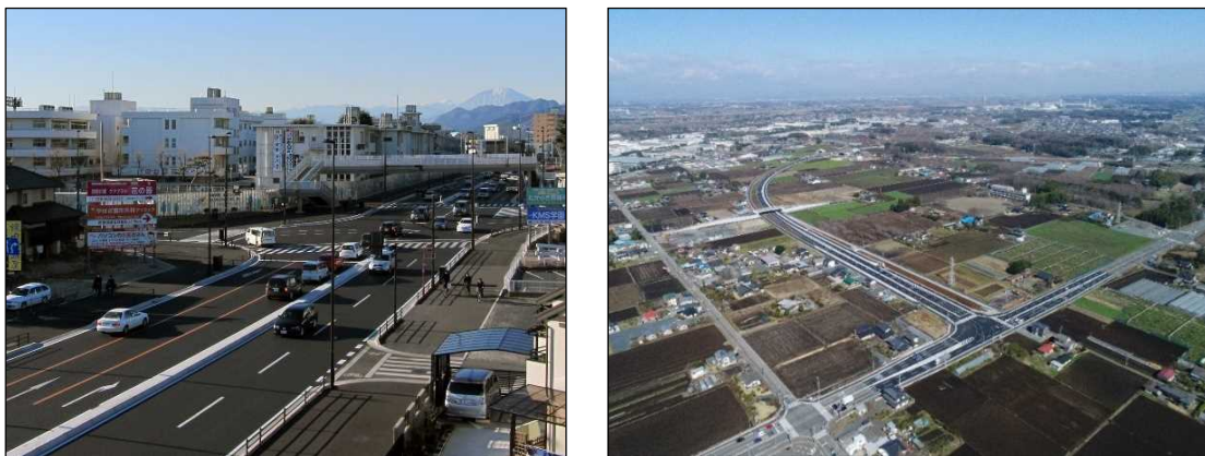
図 3-3-10：現道拡幅及びバイパス道路の整備状況 （県道宇都宮今市線（大通り）、国道 408 号 真岡南バイパス）
