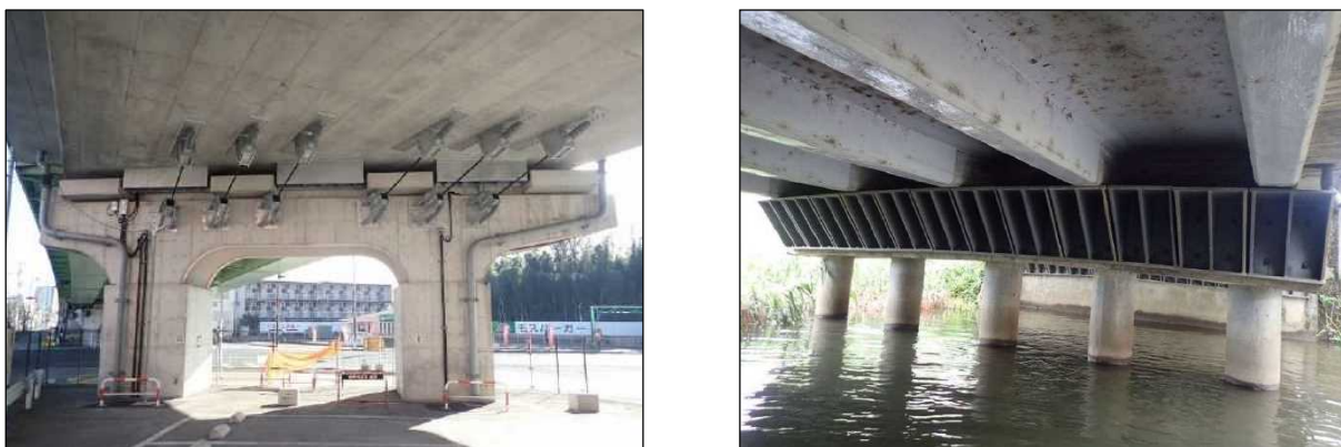
図 3-3-12：道路橋の耐震補強状況（県道宇都宮向田線、桐生岩舟線）
