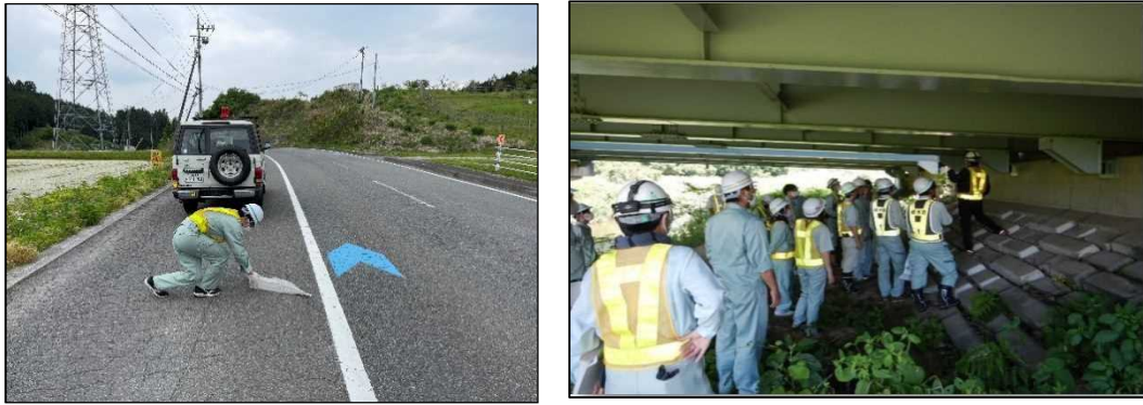
図 3-3-8：道路パトロール及び橋梁点検状況
