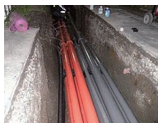
管路の浅層埋設
