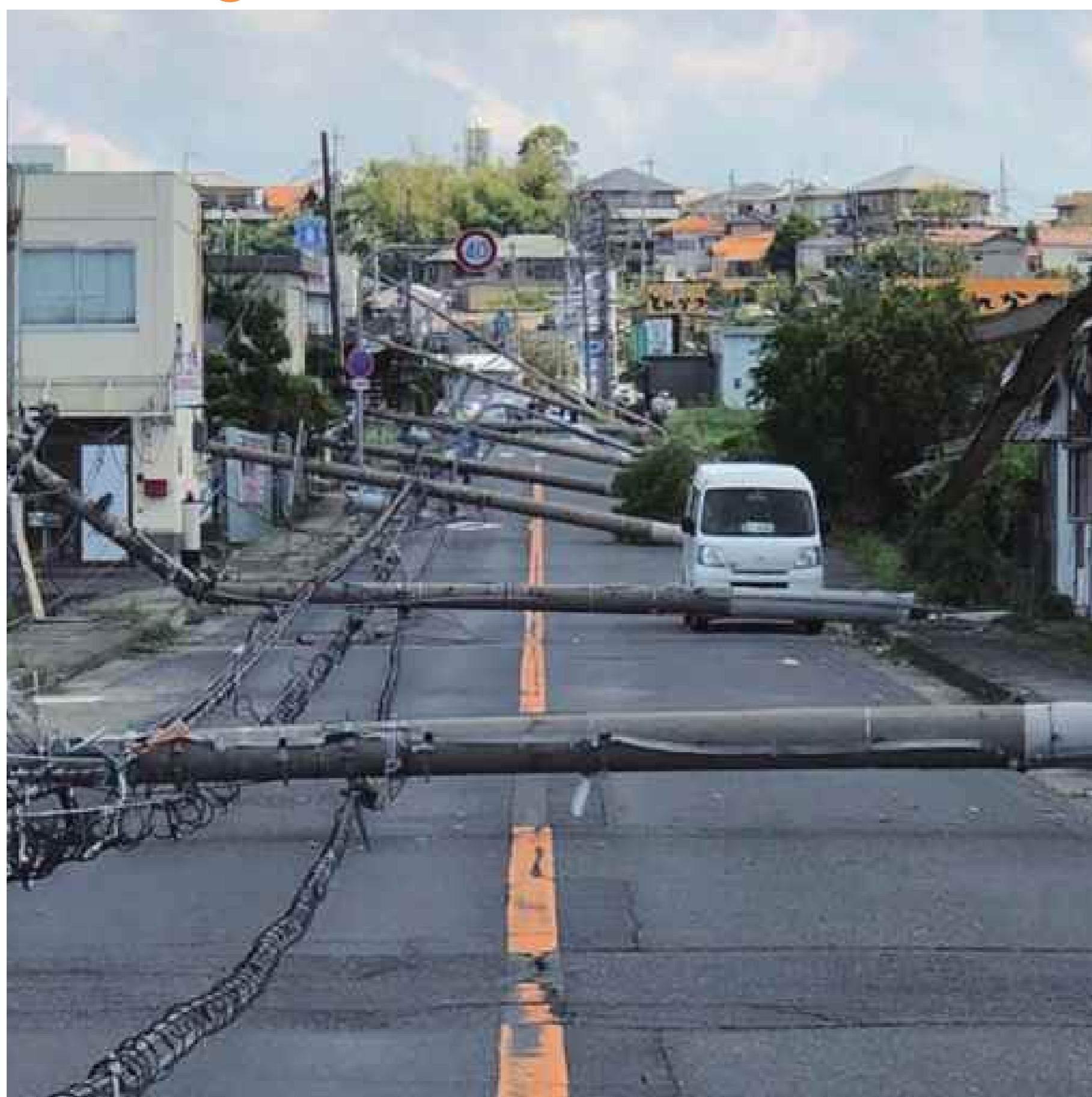
台風21号による電柱倒壊の様子(大阪府泉南市)
