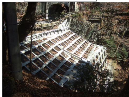
対策状況（猿岩トンネル先）
