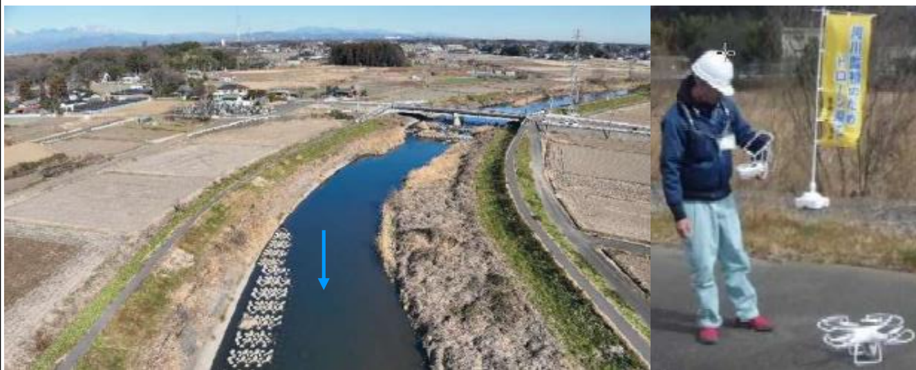
UAVを活用した目視点検
