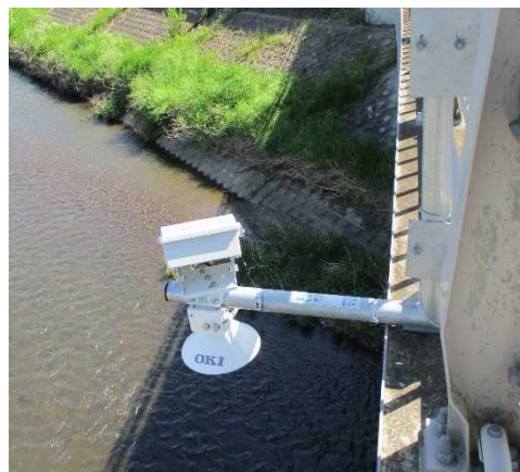
設置箇所一覧(20河川、23箇所)
