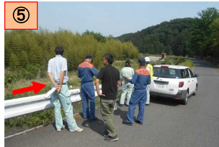
⑤栃木土木の点検状況(5/27) 一級河川永野川(栃木市岩出)
