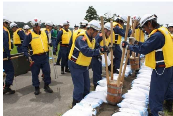
積み土のう工法
