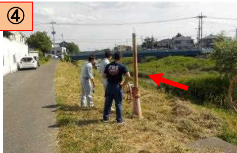
④安足土木の点検状況(5/30) 一級河川菊沢川(佐野市大橋町)
