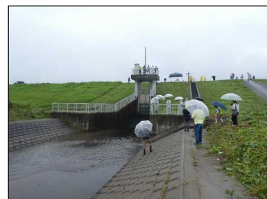
【城東地区樋門操作訓練】
