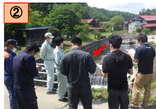
②大田原土木の点検状況(5/25) 一級河川奈良川(那須町寄居)
