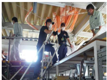
■鹿沼土木の点検状況(5/29)
