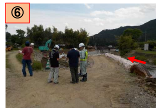
⑥日光土木の点検状況(5/28) 一級河川行川(日光市小代)
