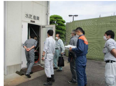
■安足土木の点検状況(5/28)
