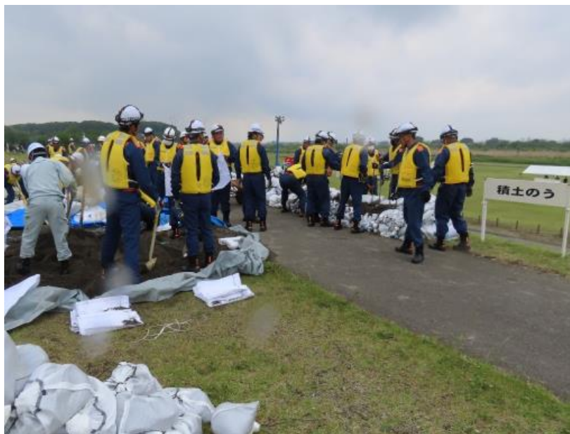
【積土のう工法】
