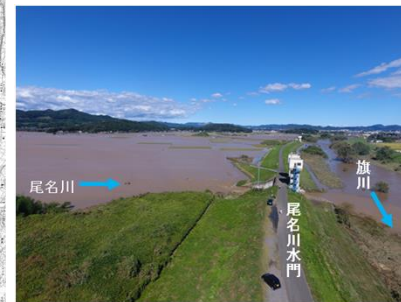
（足利市 尾名川水門付近）
