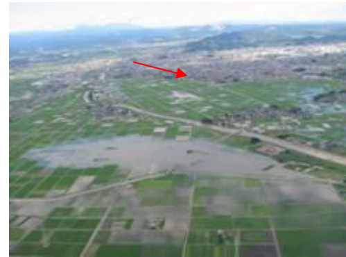
秋山川の浸水状況【平成 14 (2002) 年 7 月】 (渡良瀬川合流付近)
