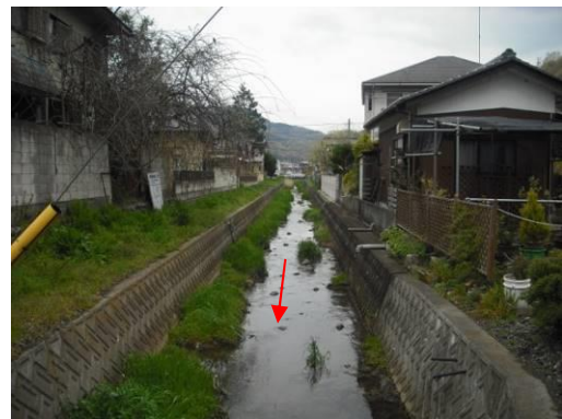
蓮台寺川（ みえばし 三重橋より約 600m 上流付近）
