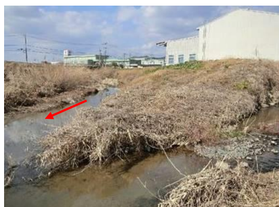
はさまはし 尾名川 (迫間橋下流付近)
