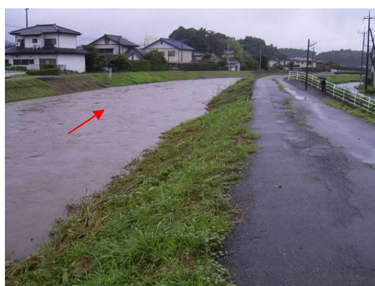
名草川の出水状況【平成 18（2006）年 7 月】 （足利市宮前橋下流付近）
