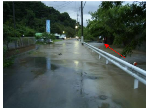
蓮台寺川の出水状況【平成 20（2008）年 8 月】
