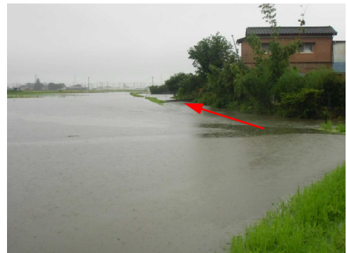
姥川の出水状況【平成 27 (2015) 年 7 月】 (足利市普門寺橋より約 200m 下流)
