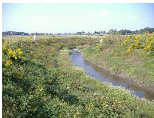
武名瀬川完成部分
