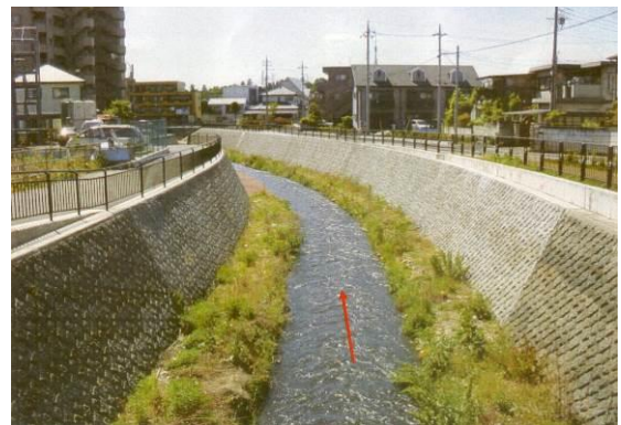
御用川完成部分
