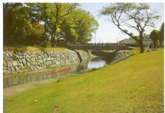
御用川完成部分 (緩傾斜区間)
