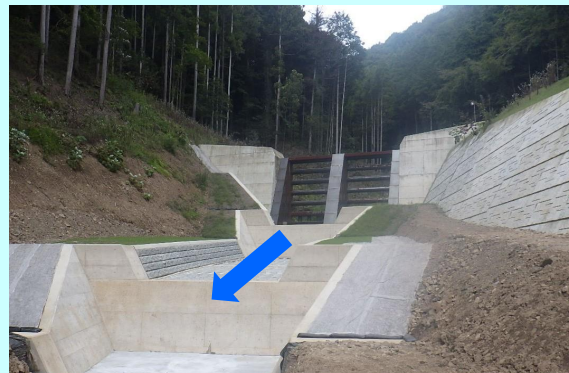
えん堤の整備を行って安全に
