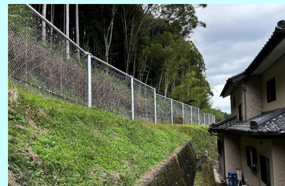
防護柵の整備を行って安全に
