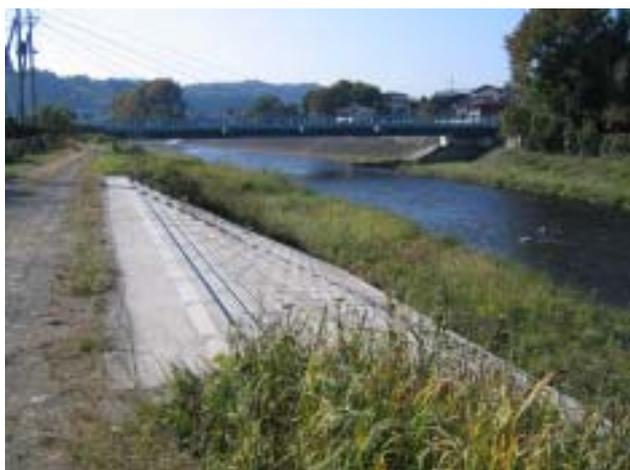
図 - 15 平館橋上流階段式護岸
