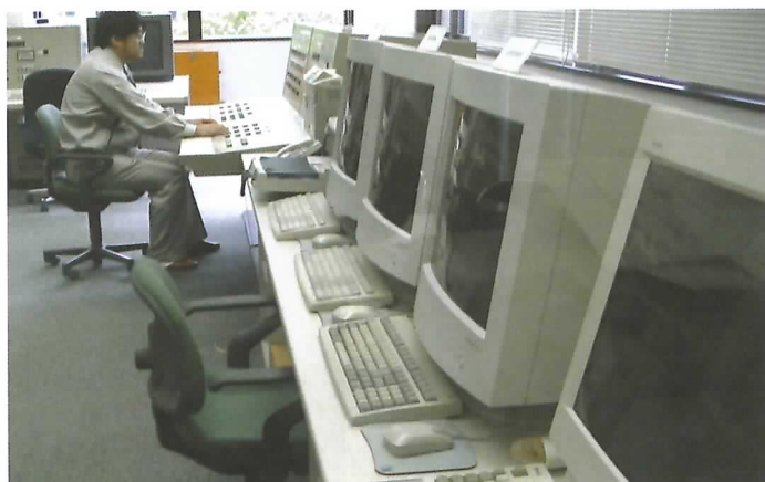
中禅寺ダム管理所(操作室)
