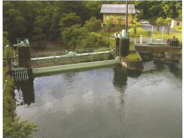
中禅寺ダム管理所（上流より望む）
