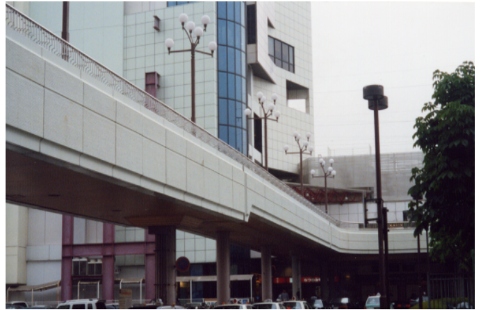
明るい色調と、桁裏もすっきりと整理することで、圧迫感を抑制している。(宇都宮市)
