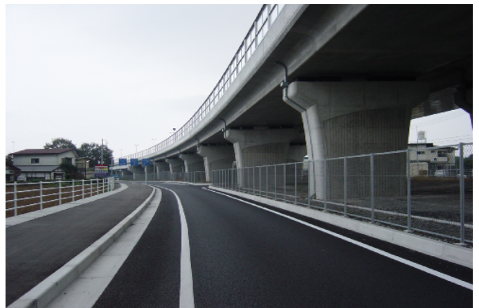
高架道路の橋脚に、緩やかなカーブを持った意匠が施されている。(宇都宮市)
