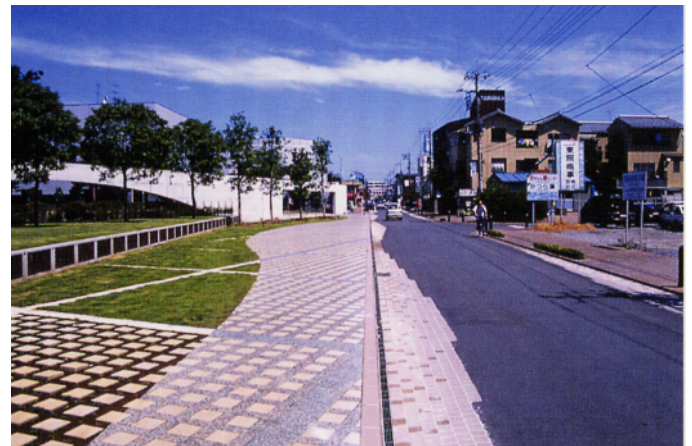
広場と歩道を一体的に整備し、広々とした空間がネットワークの拠点となっている。(小山市)
