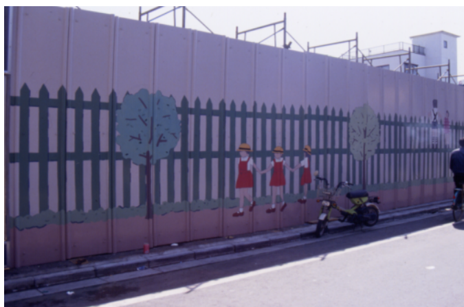
工所用仮囲いにペイントを施し、圧迫感、不安感を与えがちな空間に対し、親しみやすさを演出している。(川越市)
