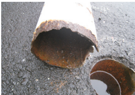
ポール看板の倒壊
