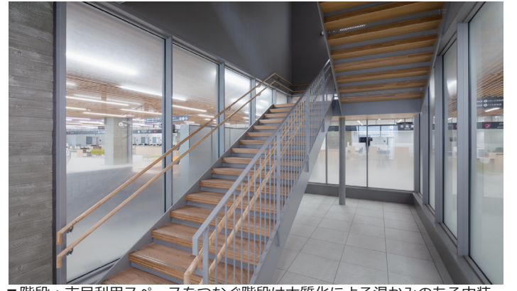
■ 階段：市民利用スペースをつなぐ階段は木質化による温かみのある内装
