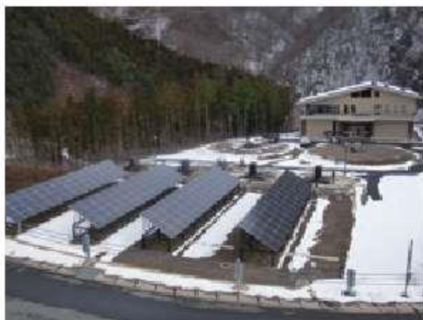
日光市湯西川水処理センター
