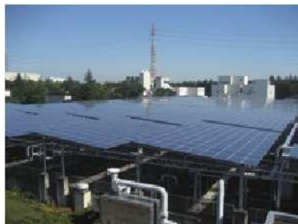
県央浄化センター
