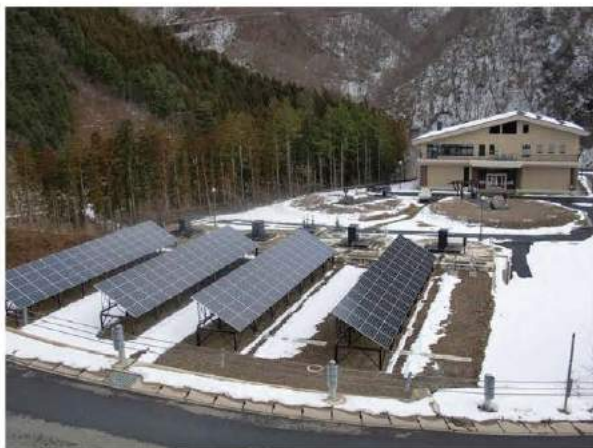
日光市湯西川水処理センター
