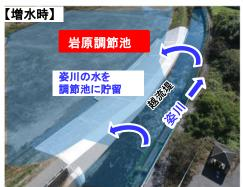
洪水時に一定の水位を越えると、越流 堤から調節池に水が流入し、洪水を一 時的に貯めることで下流の浸水被害を 軽減します。 「水位低下後」 岩原調節池 調節池に貯留した水 を姿川に排水 排水樋管
