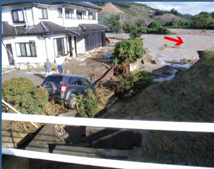
柳橋上流右岸決壊により家屋が浸水
