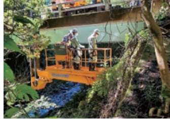
橋梁点検車による橋梁点検
