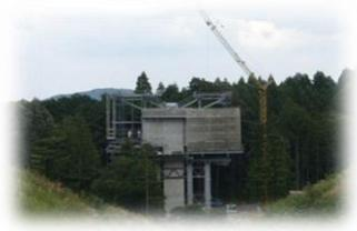
柱頭部の施工が完了後トラベラーを設置します。
