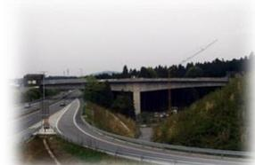
片持ち架設でA2、P5に向けて張り出していきます。(張出し施工：片側58.5m)なお、日光宇都宮道路及びJR日光線上空については夜間にトラベラーが移動し桁を施工しました。
