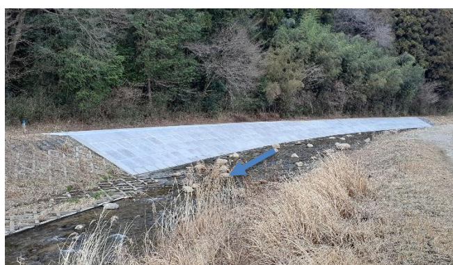
《復旧状況写真》
