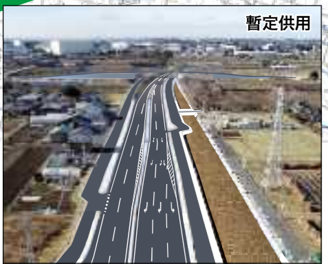
真岡南バイパス 起点部
