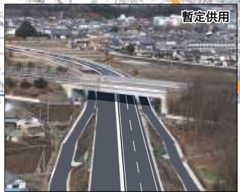
真岡南バイパス 中間部
