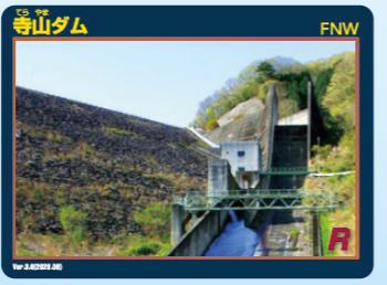
寺山ダム(S59年度完成)
