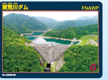
東荒川ダム(H2年度完成)
