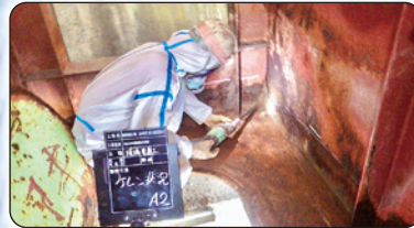
【橋梁補修の作業状況】
