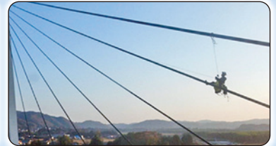
【橋梁点検の例(烏山大橋・ロープアクセス)】
