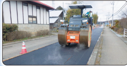
舗装修繕工事(施工中)
