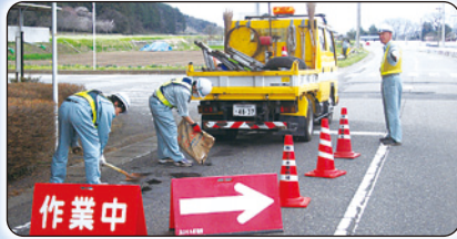
応急舗装修繕作業
