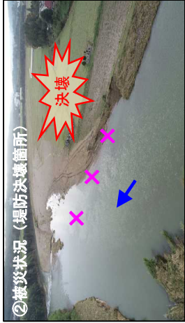
③被災状況（堤防決壊箇所）
