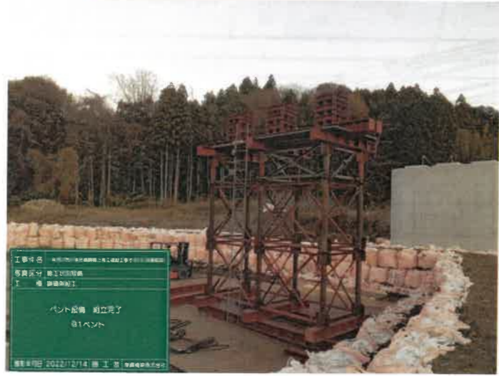
4. ベント設備組立
