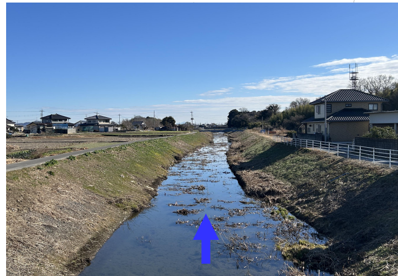
施工後(久野橋下流 2024年12月撮影)
