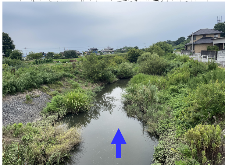
施工前(久野橋下流 2023年7月撮影)
