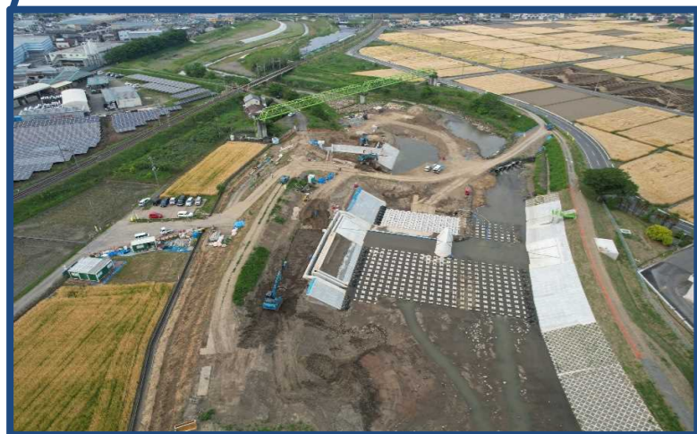
堰下部工設置工事その3 (株)東日本土木 堰周辺の護岸工事を実施しています。
