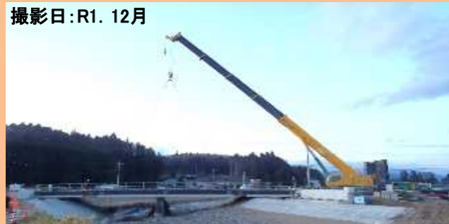
県民の森矢板線下太田橋PC橋上部工建設工事 プレビーム桁架設状況
