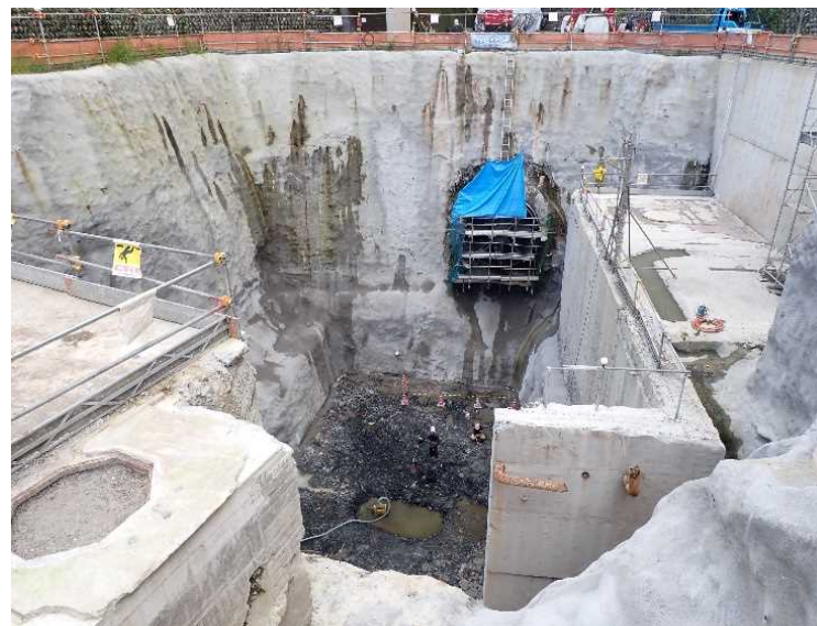
令和3(2021)年9月 建屋基礎解体完了
