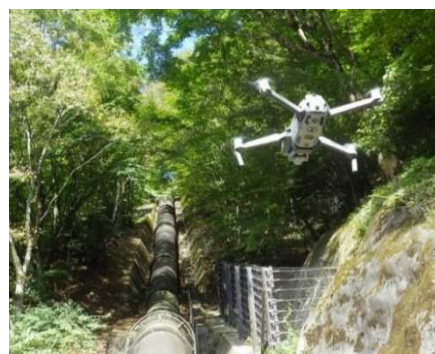
ドローンを使用した保守管理
