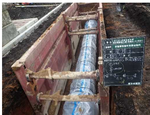
防食対策のためポリエチレンスリーブ被覆
