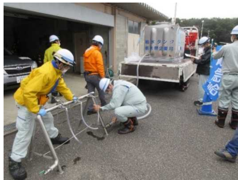
給水車による応急給水訓練
