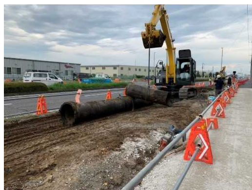
既設配水管撤去
