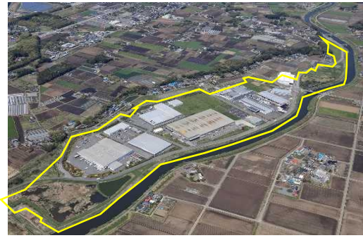
大和田産業団地（真岡市）
