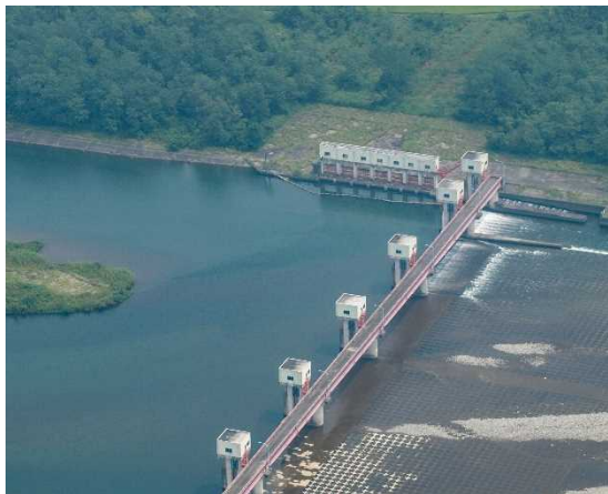
取水施設(岡本頭首工)
