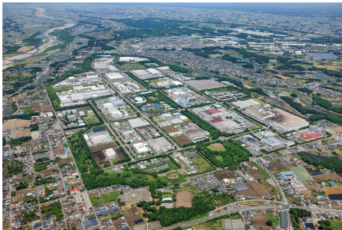
工業用水給水対象区域の一つである清原工業団地
