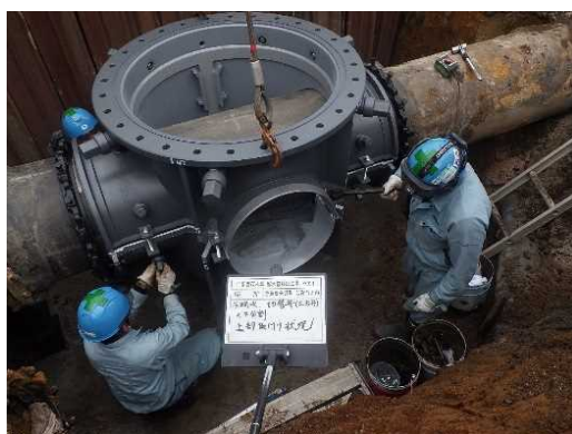
不断水バルブ設置工事
