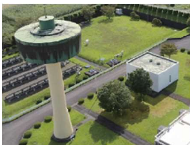
高架水槽(北那須水道事務所)
