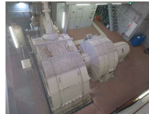
水車・発電機 (主要機器製作据付等工事)
