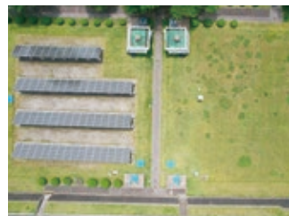
◇浄水池・調整池
