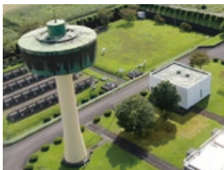
◇高架水槽・塩素混和池
