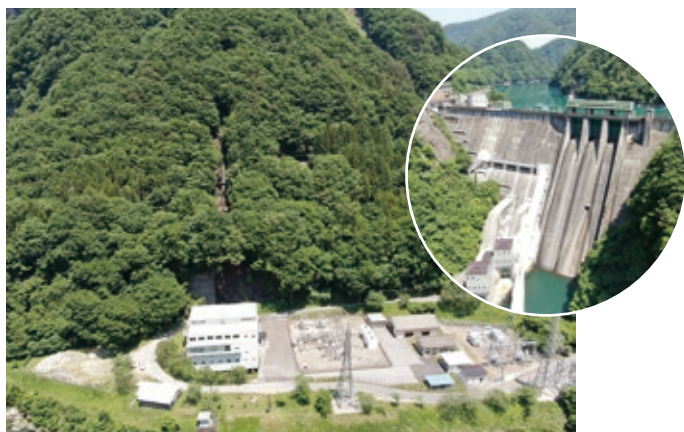
▲川治第一発電所と五十里ダム 昭和31(1956)年に運転を開始した最初の県営発電所です。五十里ダムから取水して発電しています。
