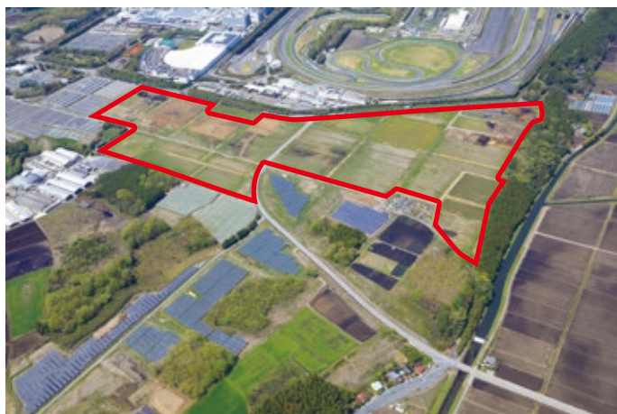
▲令和2(2020)年～令和4(2022)年 芳賀第2工業団地造成
