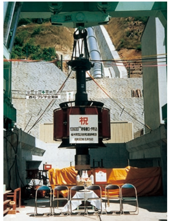
▲発電機ロータ吊込式 (昭和60(1985)年8月5日・足尾発電所)
