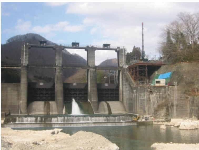
▲平成18(2006)年 小網発電所建設工事
