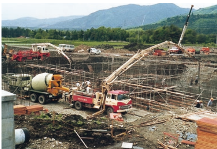
▲薬品沈でん池築造工事（昭和51(1976)年・北那須水道事務所）
