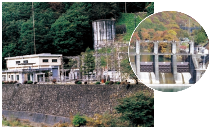
▲川治第二発電所と小網ダム 川治第一発電所で使用した水を小網ダムに貯めて発電しています。
