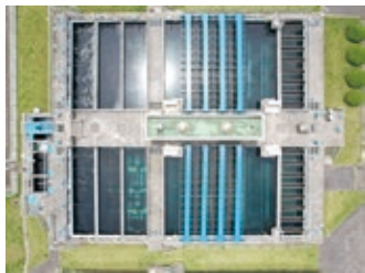
◆薬品沈でん池
