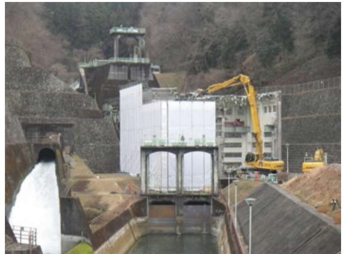
▲令和2(2020)年～ 風見発電所全面改修事業現地工事開始
