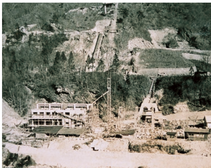
▲川治第一発電所建設工事全景
