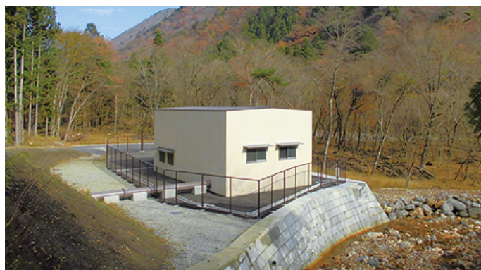
▲令和3(2021)年 小百川発電所営業運転開始
