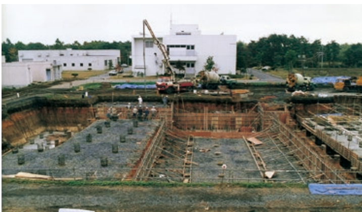
▲薬品沈でん池築造工事（昭和60(1985)年・鬼怒水道事務所）
