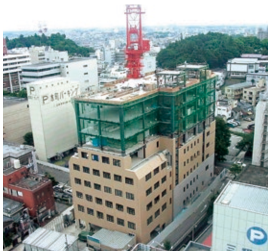
▲建設中の栃木県本町合同ビル
