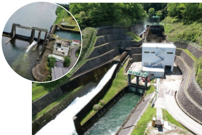
▲風見発電所と佐貫頭首工 県営発電所の中で最も使用水量が多い発電所です。佐貫頭首工から取水し、農業用水路の落差を利用して発電します。令和2(2020)年10月から発電所を停止してリニューアル工事を行い、令和6(2024)年3月に運転を再開しました。
