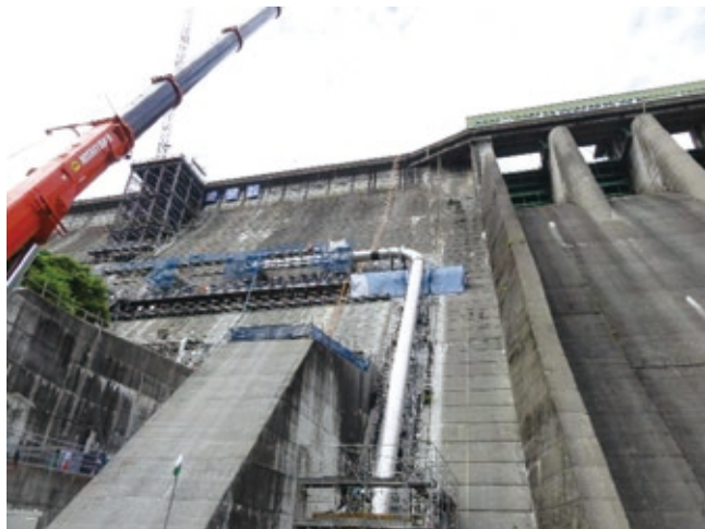
▲平成27(2015)年～ 五十里発電所建設工事
