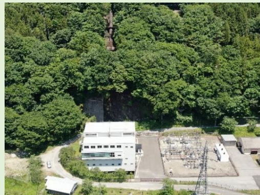
川治第一発電所
