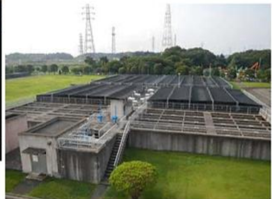
鬼怒工業用水道施設の全景
