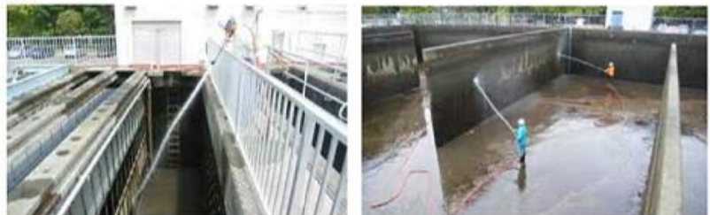
工水薬品沈澱池及び配水池清掃作業
