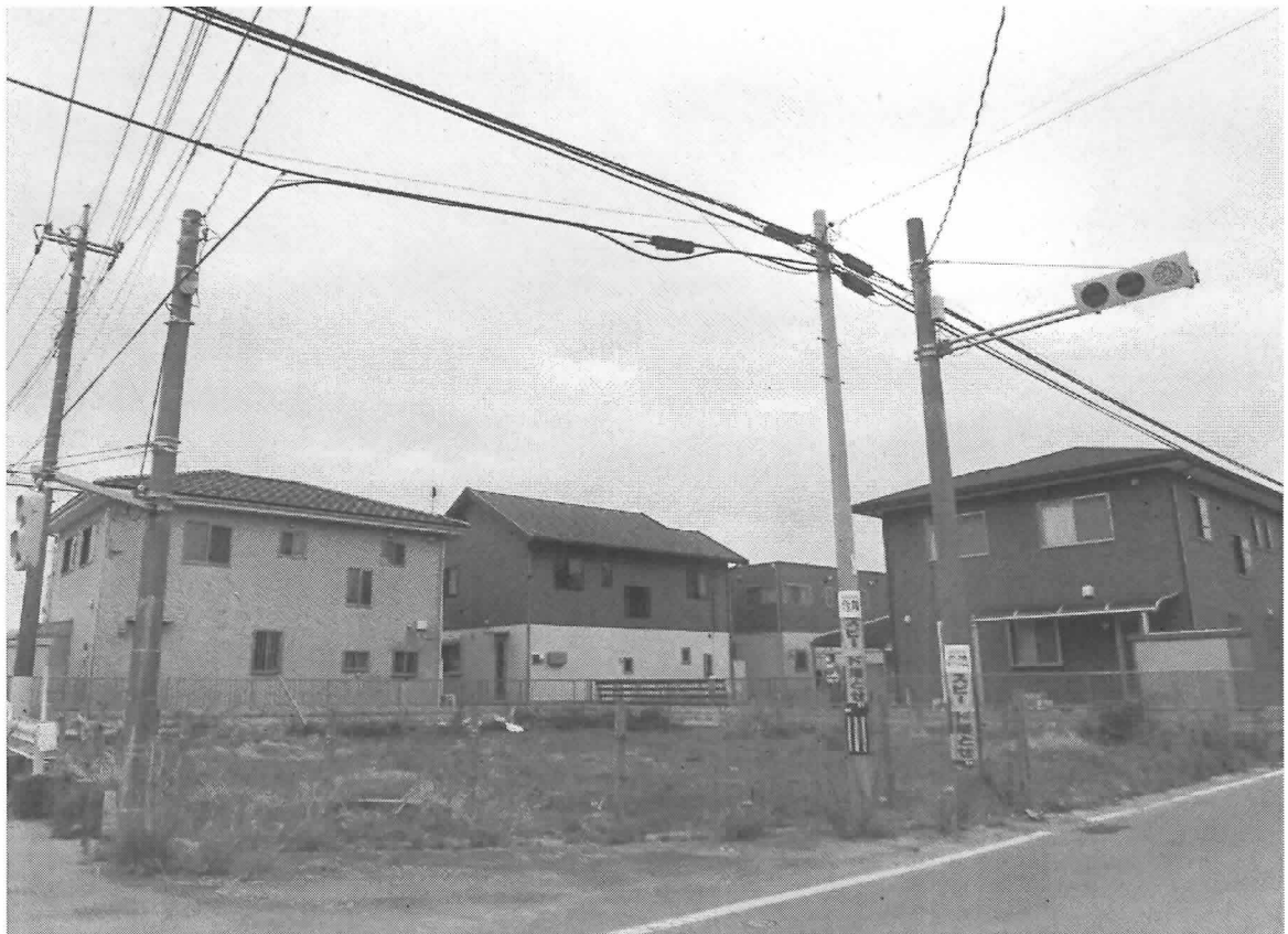
対 象 物 件 の 北 東 側 から 西 方 を 見 て 撮 影
