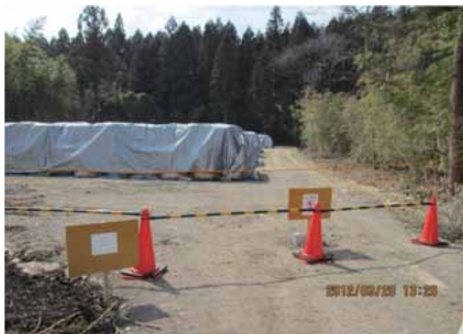
【8,000Bq/kg 超：盛土等による隔離一時保管(腐葉土)】
