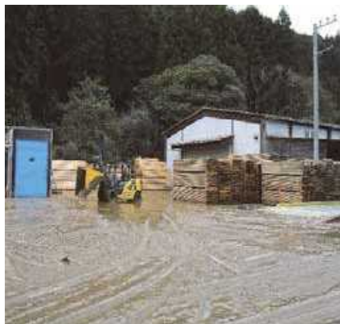
製材品の被災状況（鹿沼市内）
