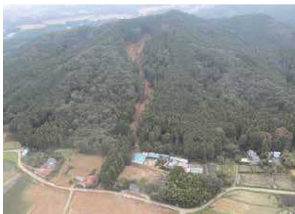
被災状況（宇都宮市下小池町 下小池二号沢）
