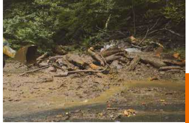
日塩有料道路 復旧作業状況
