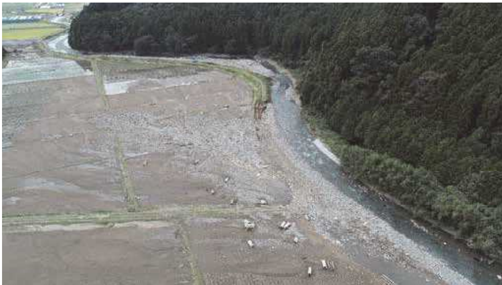
矢板市 河川の決壊による農地や水路の被害状況
