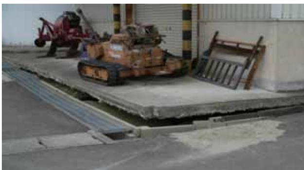
【液状化による地盤沈下が発生した農産物集出荷施設】
