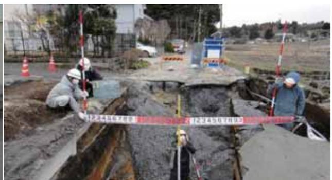
【パイプラインの破損と陥没した農道】
