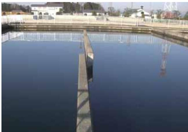
【工水配水池導流壁被害状況（傾倒）】
