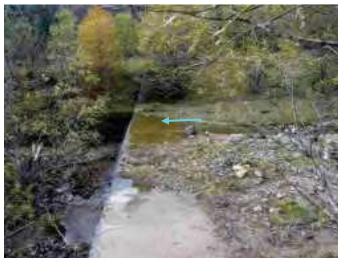
図 8.10 湯川砂防堰堤堆砂域の状況
