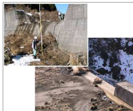
砂防施設点検による 噴火後の危険度検討
