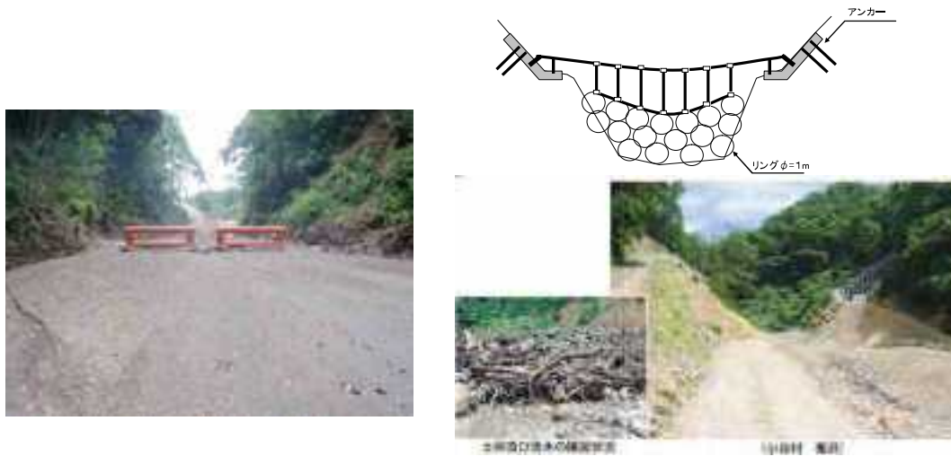
図 8.4 流木対策の事例 (左：鋼製牛柵 (新燃岳)、右：ワイヤネット)
