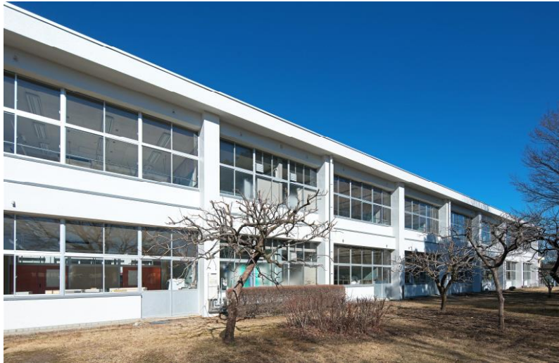
「栃木県立学校施設長寿命化保全計画」に基づき 改修を実施した校舎
