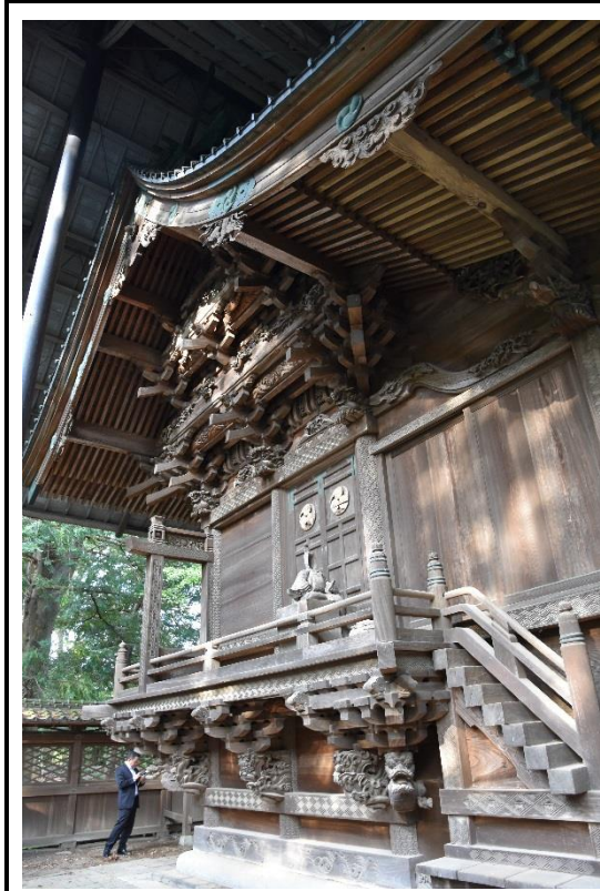
本殿（西側から）
