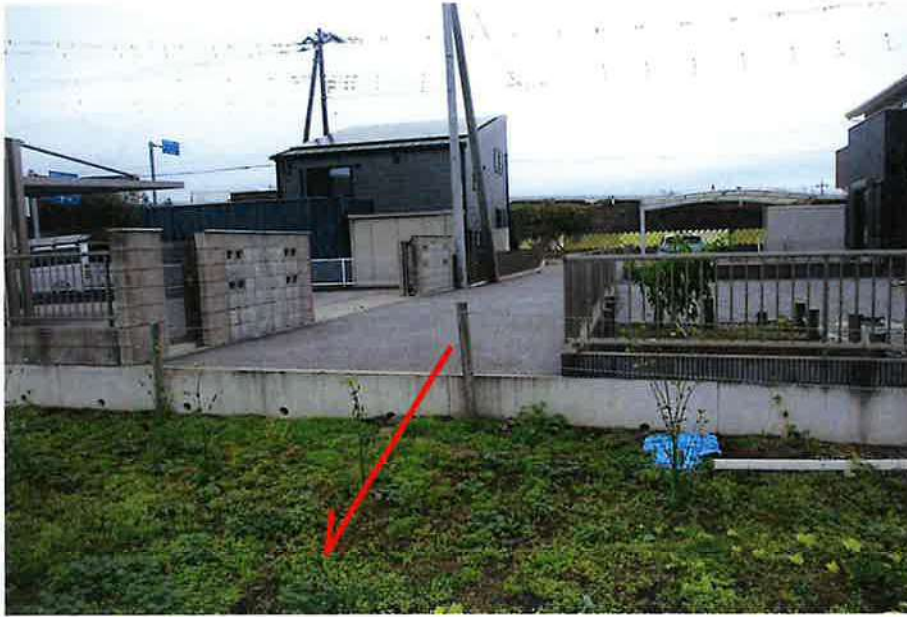
北西側隣接地の敷地延長部分の状況 (南東方より)
